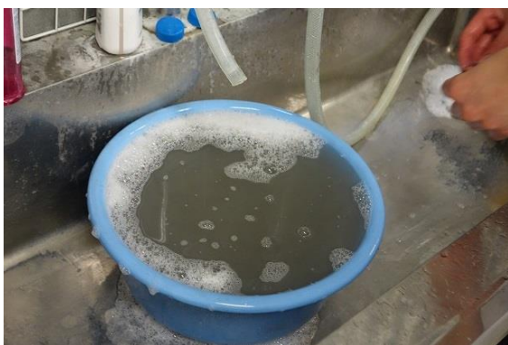
写真5 流し台の研磨剤トラップ
