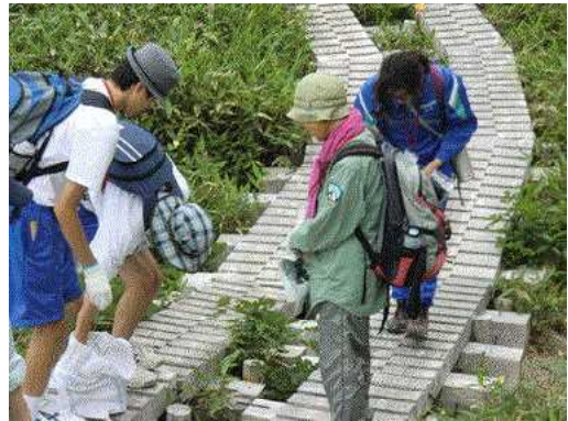
「とやまの山岳環境整備ボランティア」 木道の安全対策の強化(滑り止め板設置)
