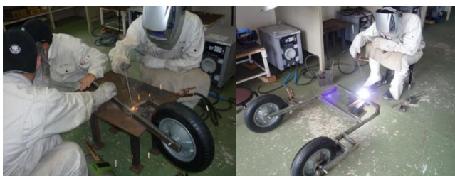
【写真2】足回りの溶接と本体の作製
