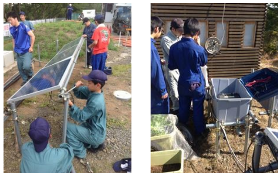
写真 1 バッテリーと太陽光パネル設置の様子
